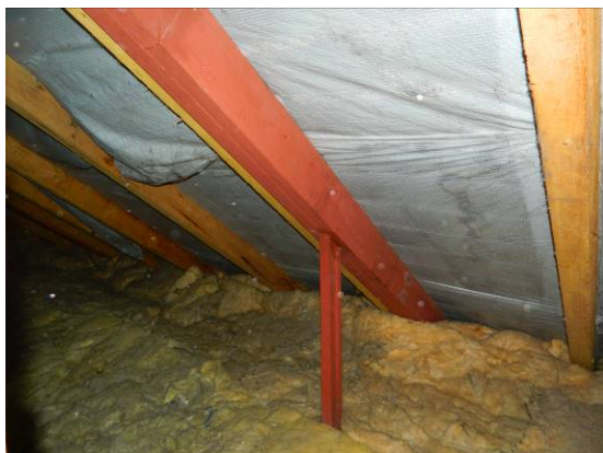
Ocelový nosník stropní konstrukce nad podkrovím – součást ocelového rámu krovu
