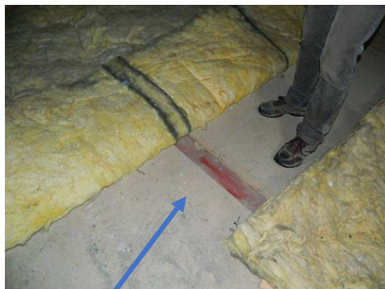
Ocelový nosník stropní konstrukce nad podkrovím – součást ocelového rámu krovu
